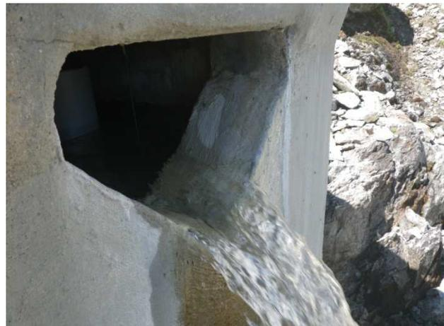
Le débit sortant peut donc être calculé par une loi mathématique, en fonction de la hauteur d'eau mesurée :
