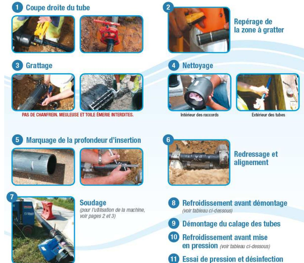
Figure 20 : Procédure de mise en œuvre des raccords électrosoudables de sécurité Frialen
