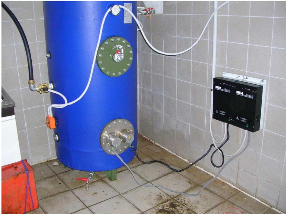
Photo 2 : Exemple de système de dissipation par l'eau associé à un ballon d'eau type RMP2000/B
