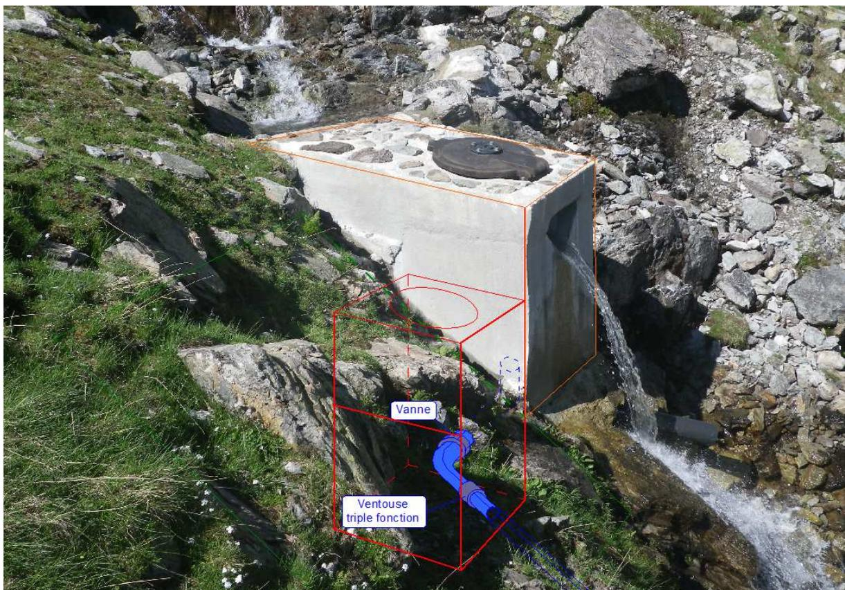
Figure 5 : Vue schématique en 3 dimensions du projet d'ouvrage de captage et d'extrémité amont de la conduite d'aménée
