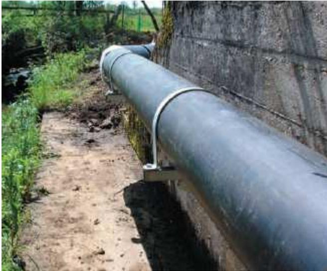
Figure 14 : Exemple d'une canalisation aérienne isolée avec les fixations adéquates
