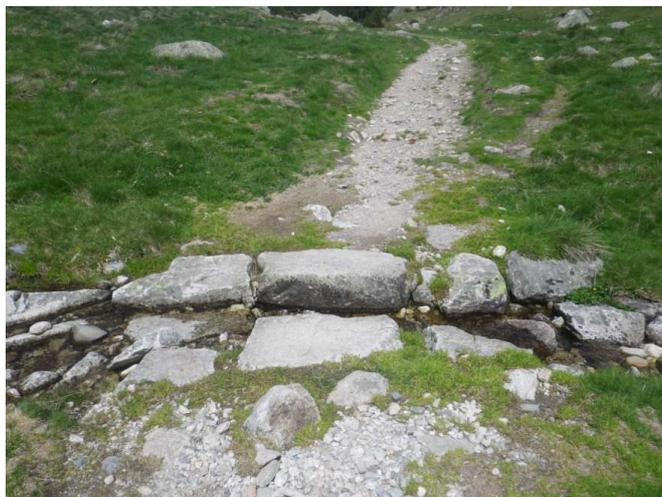
Figure 12 : Aménagement à prévoir aux traversées des talwegs le long du sentier du refuge au col du Marcadau
