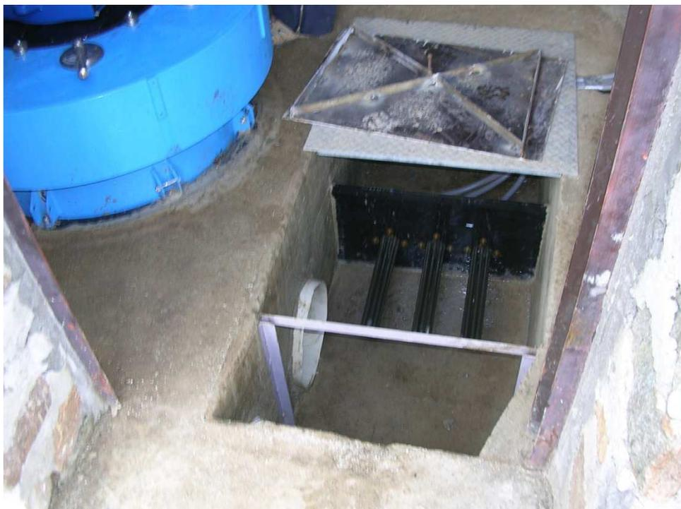
Photo 3 : Exemple de système de dissipation par l'eau associé au canal de fuite type RMP2000/B
